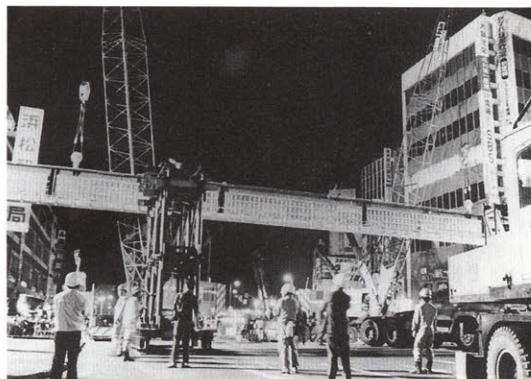
遠州鉄道高架橋梁架設現場
