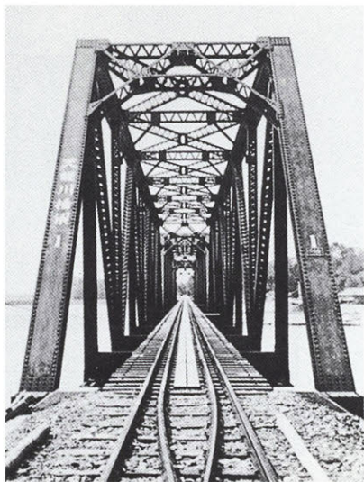
完成した二俣線天竜川橋梁
