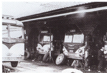
23年に完成した修理工場
