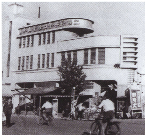
復旧した旭町の本社ビル
