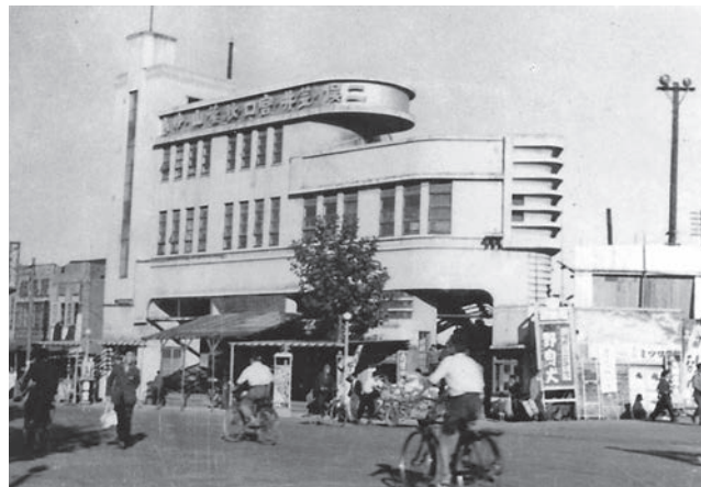
復旧した旭町の本社ビル
