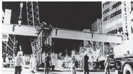
新川橋の橋桁工事(昭和58年)
