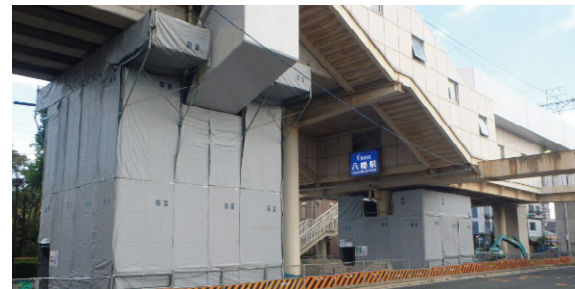
▲八幡駅耐震補強工事の様子
