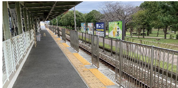
▲美蘭中央公園駅 転落防止柵
