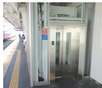
エレベーターを備えた高架駅
