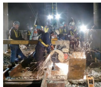
高架切替え工事の様子
