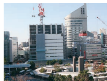
建設中の遠鉄百貨店新館
