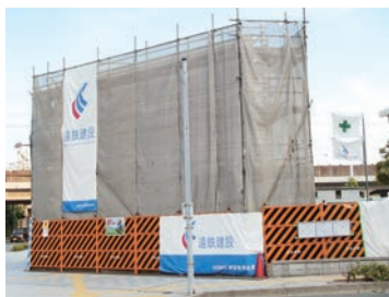
遠鉄バス松江町車庫の建設工事
