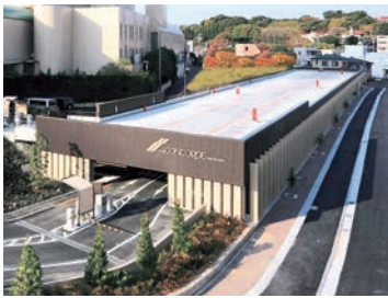
立体駐車場を整備
