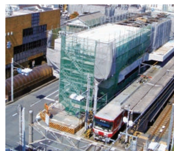
連続立体交差事業の工事風景(助信駅)
