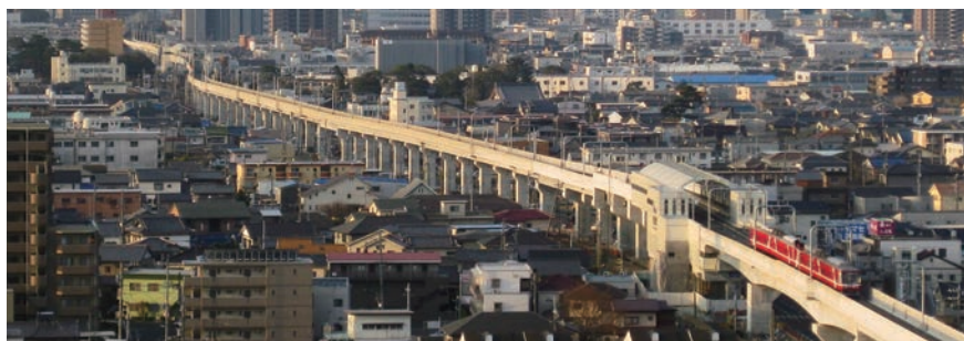
新浜松駅方面に延びる高架化された線路(曳馬駅周辺)
