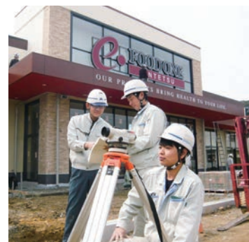
遠鉄ストア新店舗の建設
