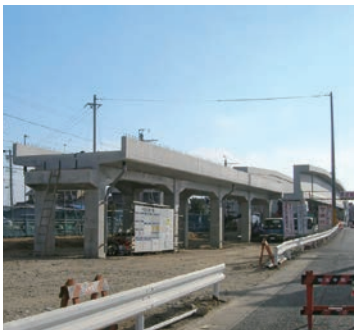
国道152号線高架の工事風景
