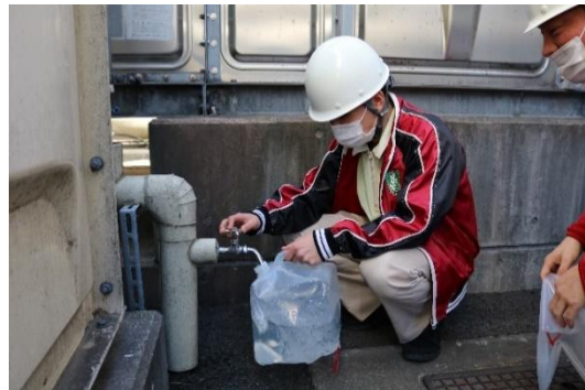
断水時に備えた給水訓練の実施
