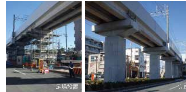
▲昨年度の工事の様子(八幡駅付近)
