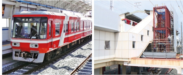
▲工事中の八幡駅
