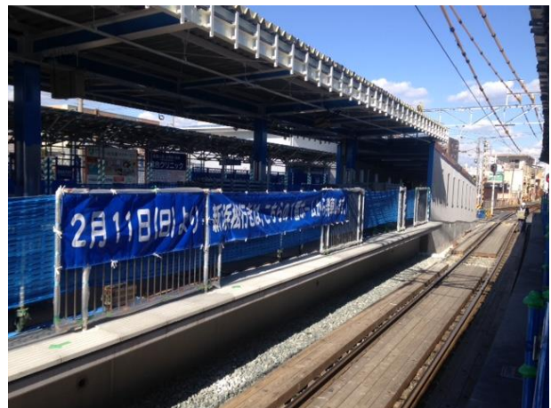
新ホームとスロープ部分
