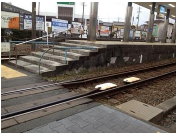
工事前の旧ホームと階段部分
