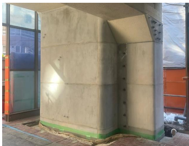
【第一通り駅耐震補強工事】
